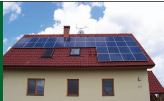
ukázka instalace na střechu RD o výkonu do 5kWp
